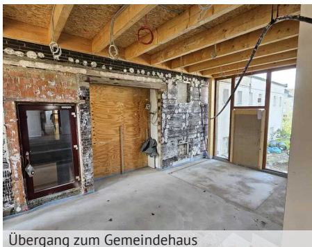
Übergang zum Gemeindehaus
