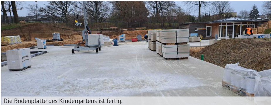
Die Bodenplatte des Kindergartens ist fertig.
