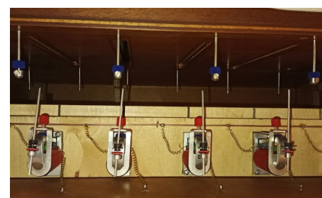
...und nach dem Reinigen wieder eingebaut.
