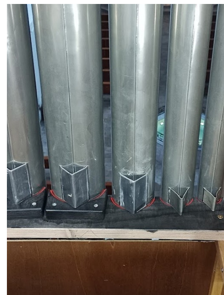
Die großen Prospekt Pfeifen erhalten zusätzliche Stützen, um weiteren Verformungen durch Instabilität vorzubeugen.
